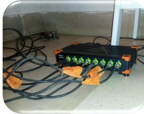
Sistema di acquisizione
