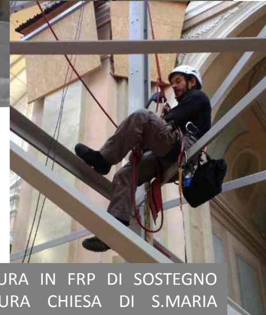
STRUTTURA IN FRP DI SOSTEGNO
