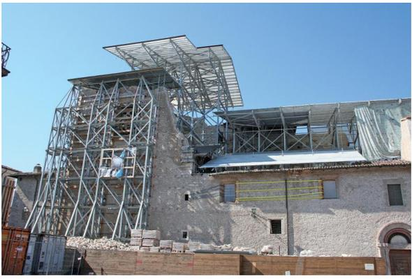
Analisi modale operativa finalizzata alla caratterizzazione dinamica della struttura di copertura provvisoria della Chiesa Santa Maria Paganica a L'Aquila. La suddetta struttura peculiare caratteristica di essere realizzata in pultrusi in vetro resina (GFRP) relativamente non si hanno specifiche raccomandazioni pro normative in merito.
