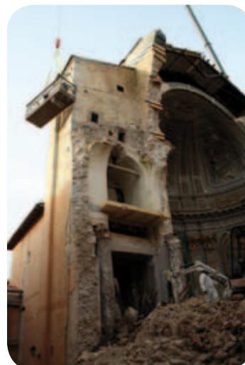
Figura 4: Fase di installazione con cestello appeso a gru
